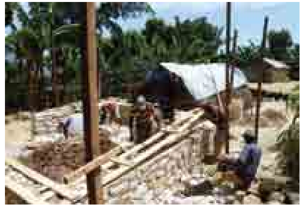
Ci-dessus, un chaînage bois horizontal est disposé tous les 65 cm de haut
