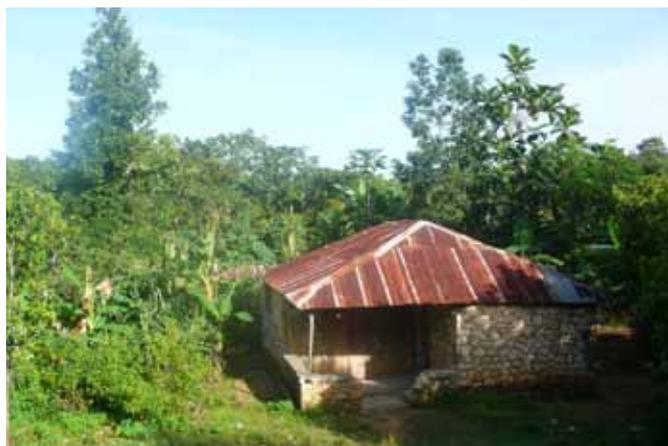
Maison construite en ossature bois avec un remplissage en maçonnerie de petites pierres (*ti wòch*) et un grenier (*galata*) en bardage bois (*planch*).
