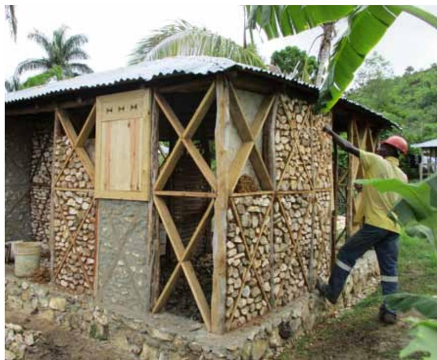
Près de 300 chantiers de réparation ont eu lieu dans la région de Grand Anse dans le cadre du projet coordonné par la Croix Rouge Suisse. Les panneaux de remplissage sont en pierres maçonnées au mortier terre, avec jointoyage au ciment.
