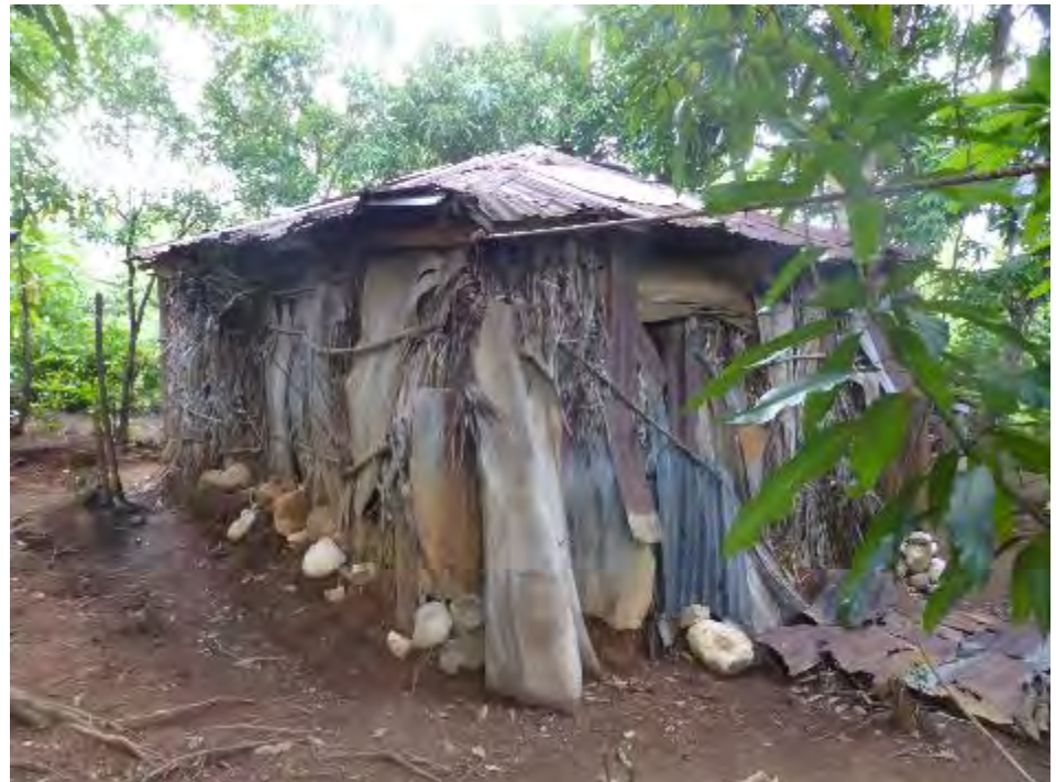
Utilisation de feuilles de palmes et de bananiers pour fermer les murs. Système de soutien de la structure par une corde.
