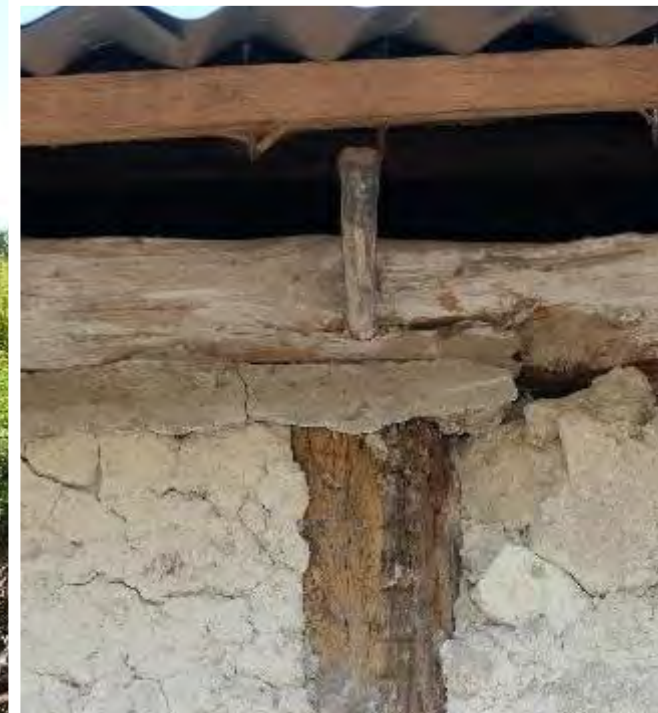
Assemblage bois tenon/mortaise avec cheville en bois
