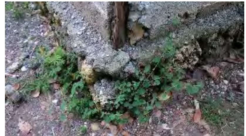
Soubassements comme masse d'usure en pied de murs. Protection de la partie basse des poteaux
