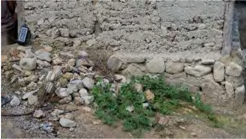
Ancrages en pied de mur et soubassements
