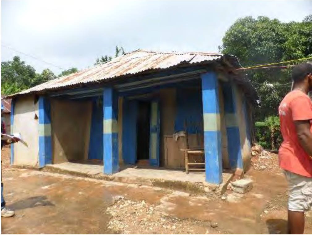
Maison OB traditionnelle dont la moitié des remplissages ont été endommagés et remplacés par des tôles.
