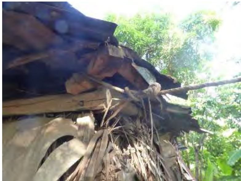
Utilisation de feuilles de palmes et de bananiers pour fermer les murs. Système de soutien de la structure par une corde.
