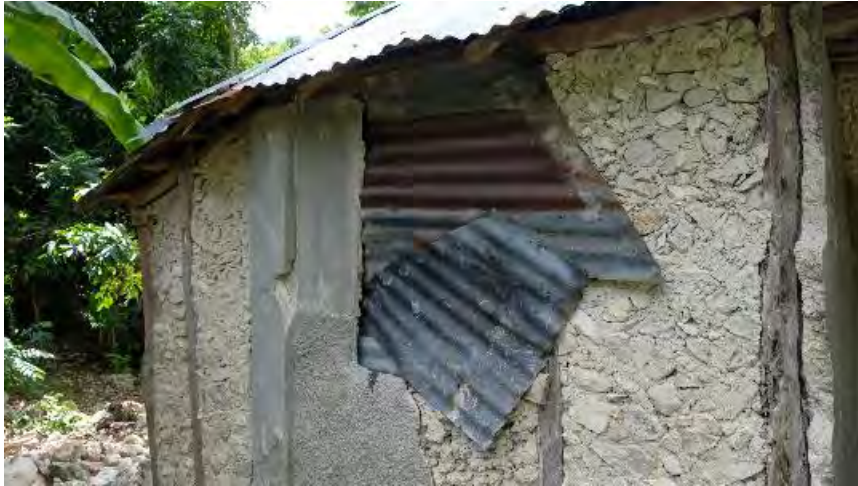
Réparations temporaires des panneaux.
