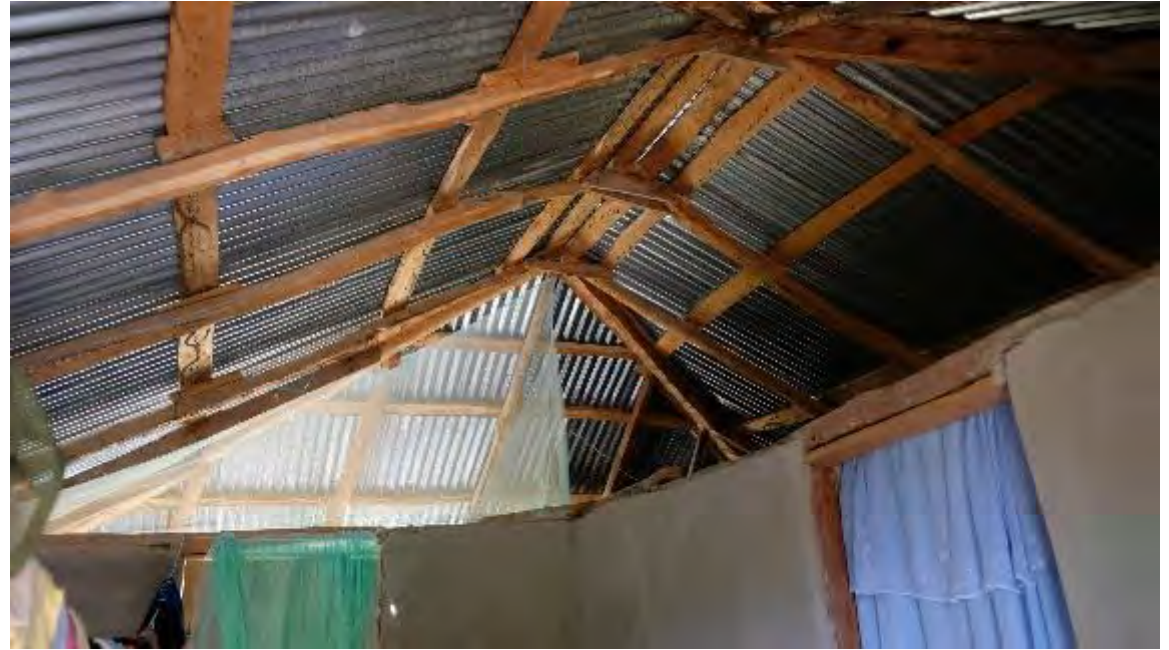
Assemblages bois en tenon/mortaise avec chevilles en bois
