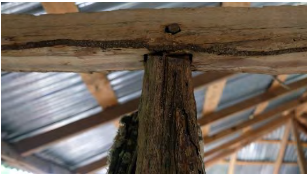
Assemblages bois en tenon/mortaise avec chevilles en bois
