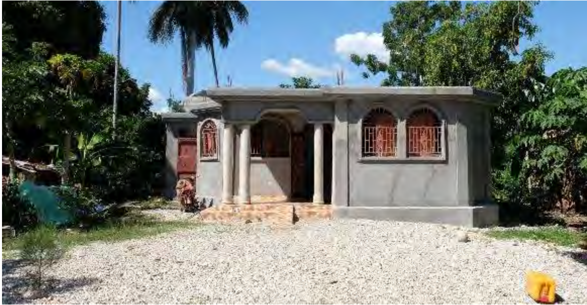
Maison maçonnerie simple de blocs + dalle, avec des dommages mineurs (légère fissure à la jonction de la dalle)
