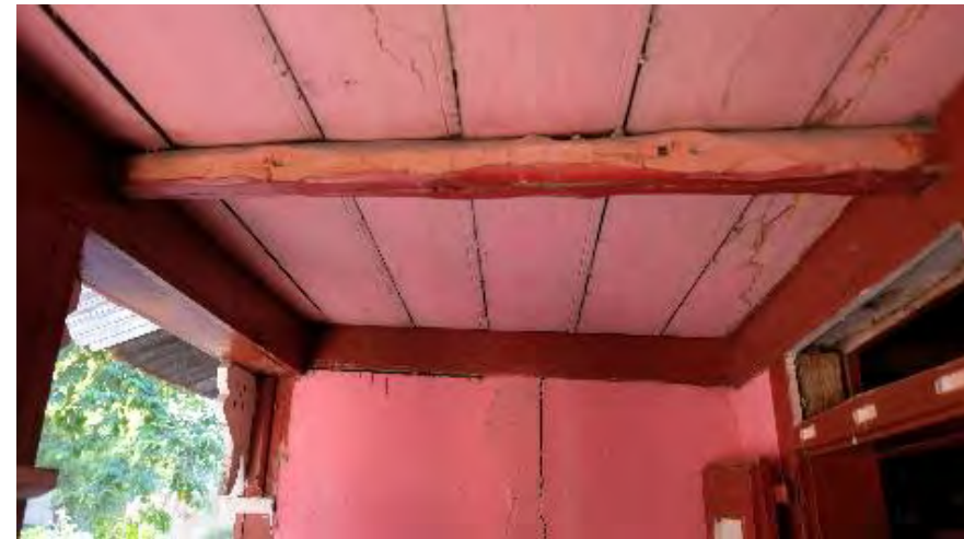
Plafonnement de la galerie avec des planches
