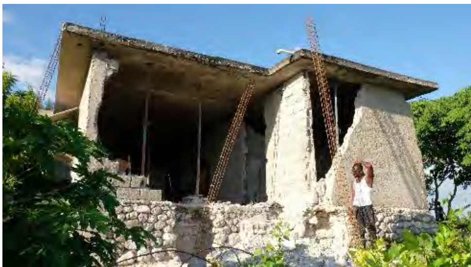
Typologies de dégradations de la maçonnerie simple de blocs.
