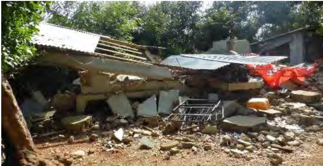
Maison « FFTP » entièrement détruite.
