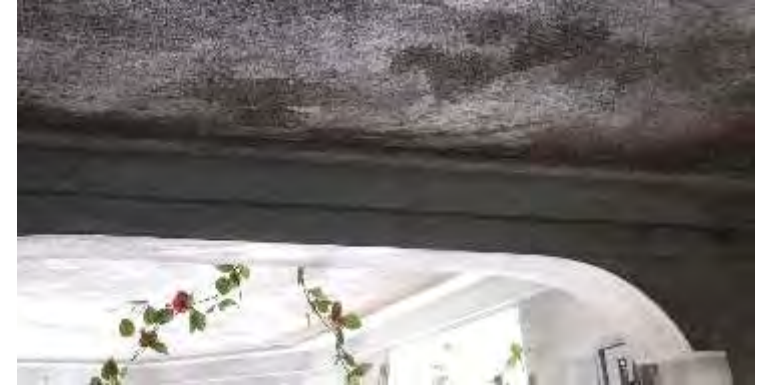
Maison maçonnerie simple de blocs + dalle, avec des dommages mineurs (légère fissure à la jonction de la dalle)
