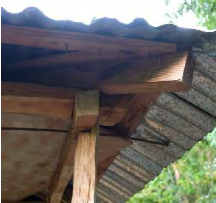
Assemblages bois en tenon/mortaise avec chevilles en bois
