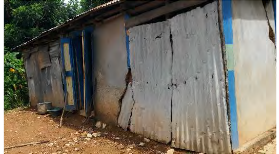
Maison OB traditionnelle dont la moitié des remplissages ont été endommagés et remplacés par des tôles.
