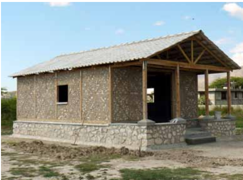
Remplissage et couverture
